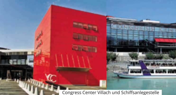
Congress Center Villach und Schiffsanlegestelle
